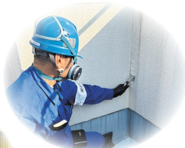
アスベスト調査
